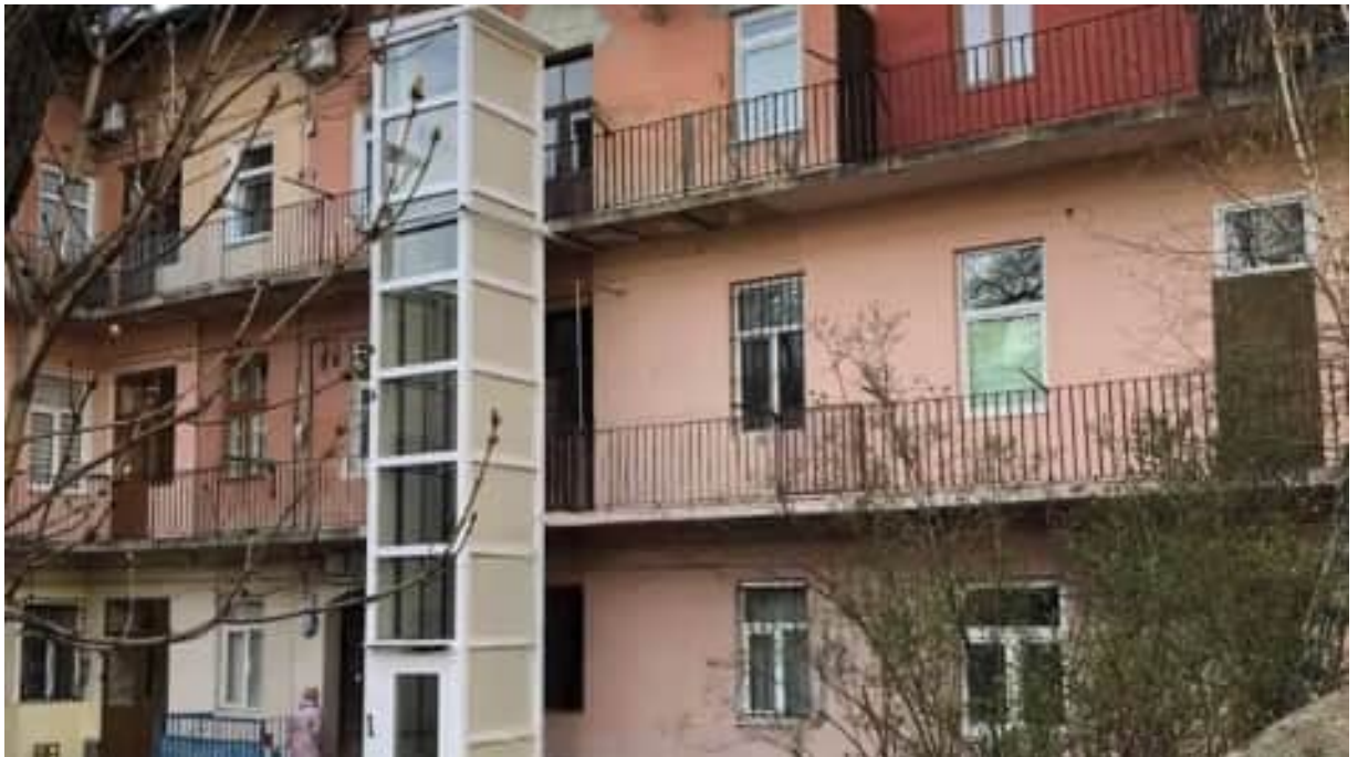
Рисунок 1.33. Приклад прибудови ліфта до галереїного будинку
