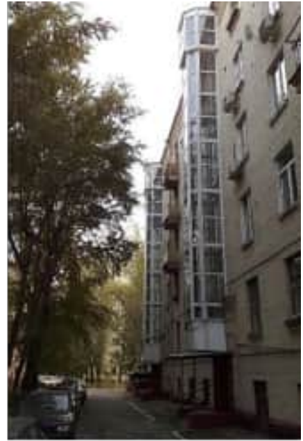
Рисунок 1.32. Приклади прибудови ліфта до сумісного зі сходовою кліткою приміщення
